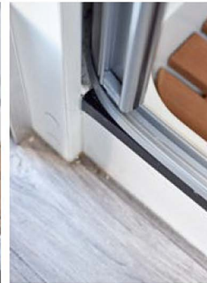
Wo Licht, da auch Schatten – oder in unserem Fall: Wasser, das sich hinter der Führungsschiene sammelte und ungehindert in den Wohnraum lief. Etwas Armaflex, abgedichtet mit Silikon, verhindert das nun.
