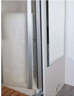
Am Spalt zwischen Magnetleiste und Tür erkennbar: Das Fangband zum Sichern der Falttür war so sehr vorgespannt, dass sie nun stark verzogen ist.
