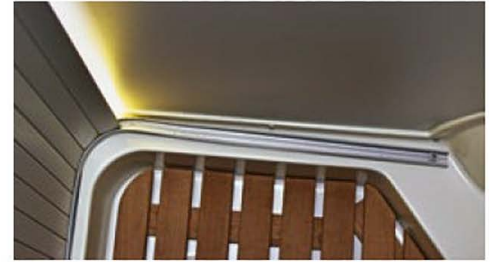
Wo Licht, da auch Schatten – oder in unserem Fall: Wasser, das sich hinter der Führungsschiene sammelte und ungehindert in den Wohnraum lief. Etwas Armaflex, abgedichtet mit Silikon, verhindert das nun.
